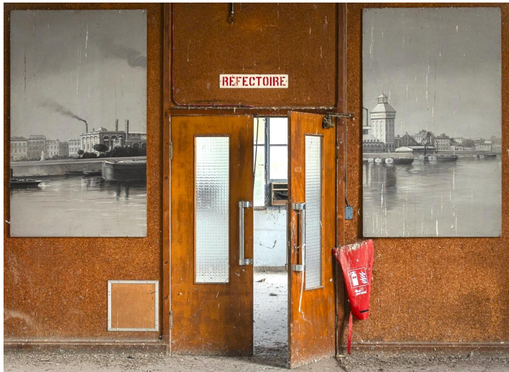
Minoterie appelée Grands Moulins de Corbeil (dossier d'Inventaire IA91001069). Ancienne centrale thermique construite en 1920 et convertie en réfectoire v. 1950. Désaffecté depuis 2005.
